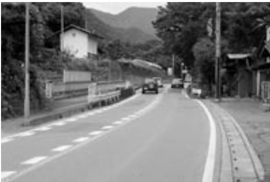
国道140号石原陸橋
