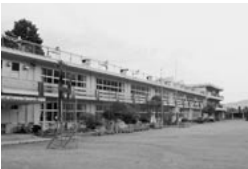
改築予定荒川東小学校
