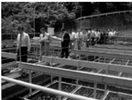
別所浄水場(建設委員会現地調査)
