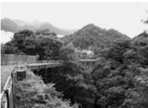
荒川安谷橋工事状況
